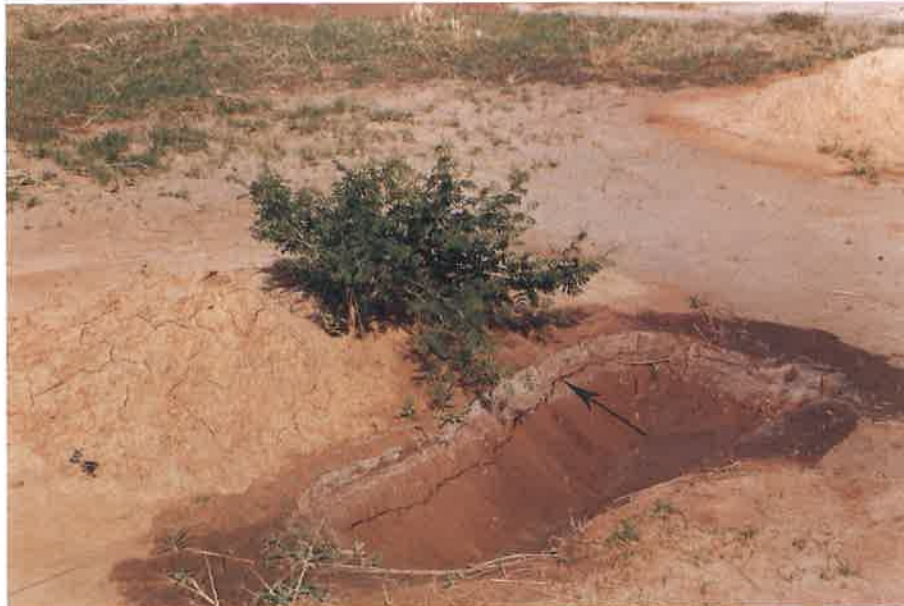
Le fossé permet le stockage, puis l'infiltration de l'eau qui ruisselle sur ce Hardé peu perméable. La flèche désigne une auréole blanche qui témoigne de la présence de sel de sodium dans le sol.
